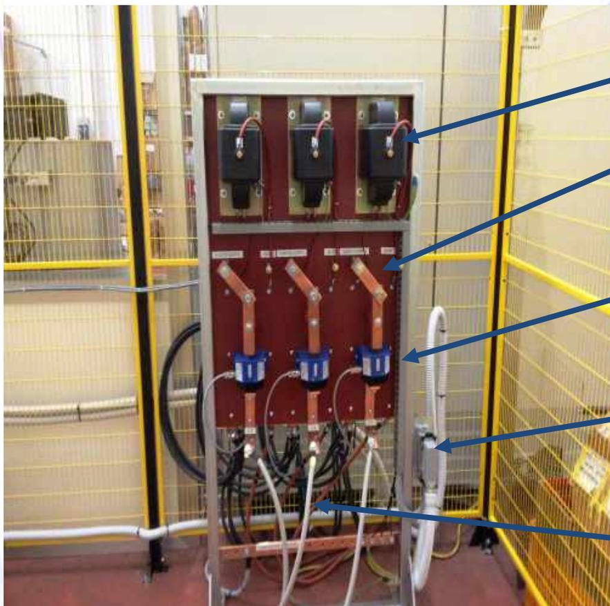
TRASDUTTORI DI TENSIONE 2Kv
